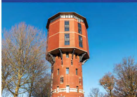
Renovatie watertoren Zwolle
